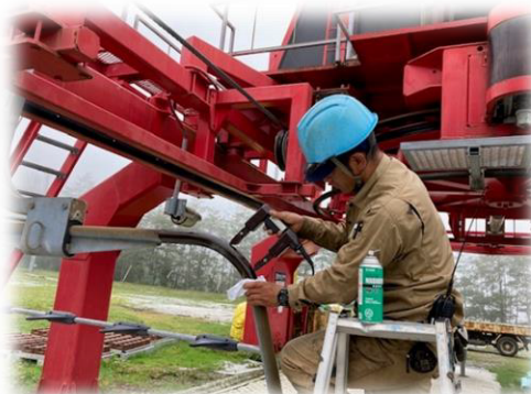
《索道技術管理者による検査》
